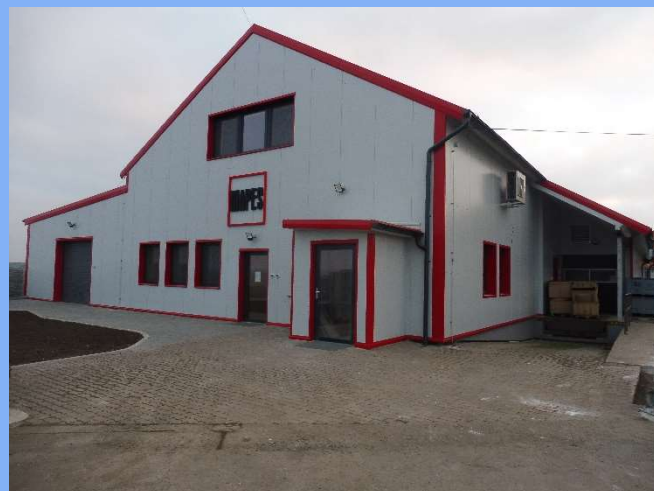
Výrobní hala Církvice - Dodávka a montáž obvodového a střešního pláště včetně klempířských prvků
