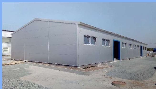
Výrobní hala Kralupy nad Vltavou - Dodávka a montáž obvodového a střešního pláště včetně klempířských prvků a výplní otvorů
