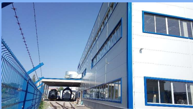
Výrobní hala Jihlava - Dodávka a montáž obvodového a střešního pláště včetně klempířských prvků, odvodnění Pluvia, ocelových konstrukcí, konstrukčních plechů a pásových světlíků
