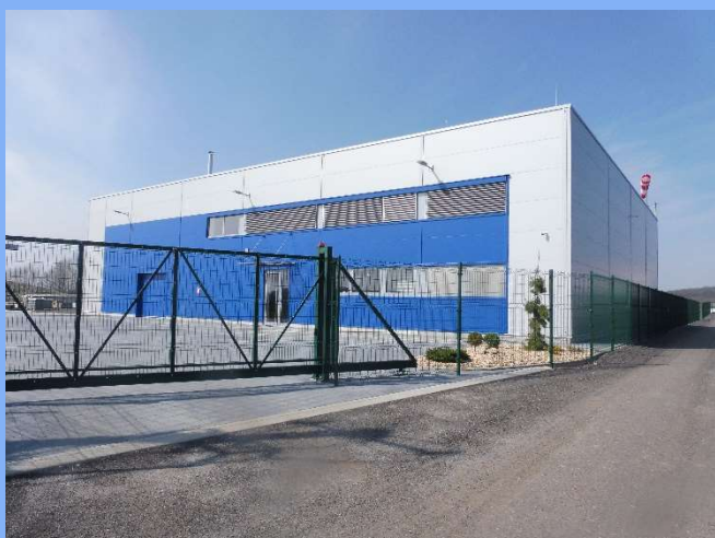
Průmyslová hala Mnichovo Hradiště - Dodávka a montáž obvodového a střešního pláště včetně klempířských prvků, ocelových konstrukcí, konstrukčních plechů
