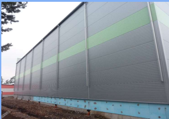
Skladová hala Hořátek - Dodávka a montáž obvodového a střešního pláště včetně klempířských prvků
